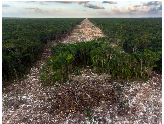
Foto: Fernando Martínez Belmar, construcción Tren Maya.
